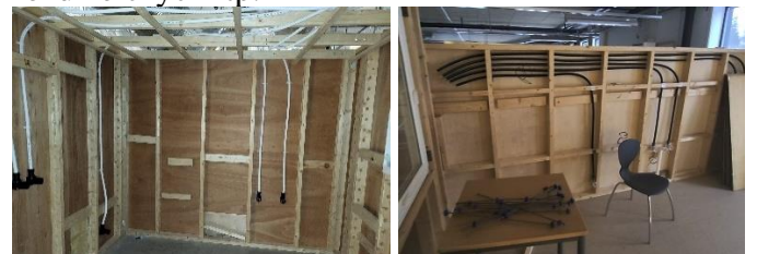
Fot: Pracownie instalatorskie
